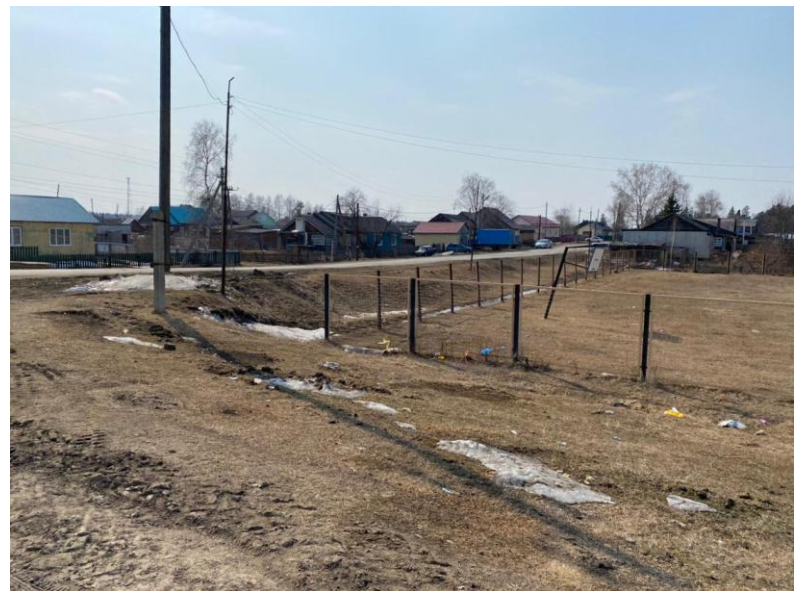
Ограждение площадки требует замены
